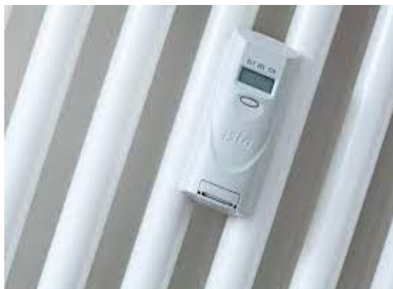
Ilustración 15. Ejemplo de repartidor de coste instalado en un emisor.
