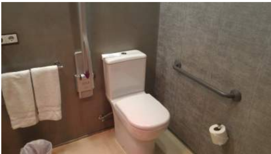
Figura 10: Inodoro con barras de apoyo
