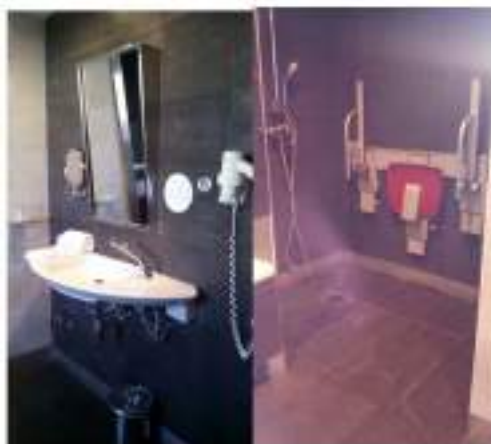
Figura 15: Baño privado de hotel con lavabo sin pedestal y ducha con asiento
